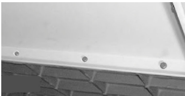
Obr. 11: Montáž ocelového prodloužení stolu
